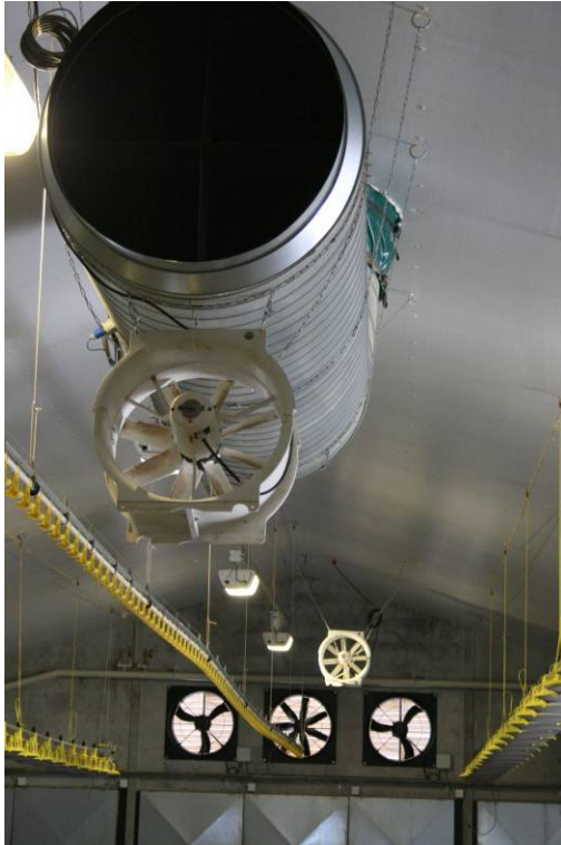
Figuur 10 Geconditioneerde lucht uit de warmtewisselaar wordt via recirculatieventilatoren (voorgrond) in de stal verdeeld
