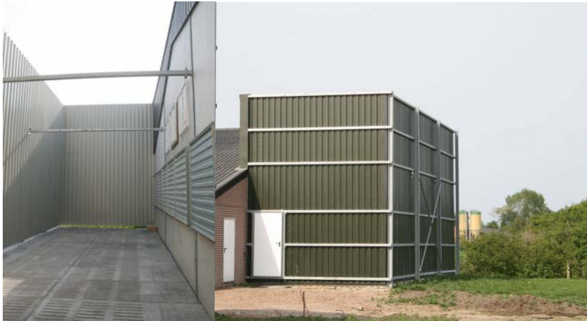
Figuur 4 Extra muur aan de afzuigzijde van de stal, om stof te vangen en de lucht in de hoogte te sturen, foto binnen- en buitenkant
