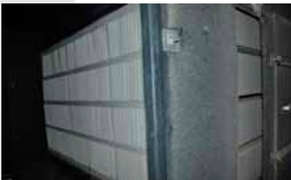
De verse lucht komt binnen door de lamellen, de warme lucht gaat langs de lamellen naar buiten
