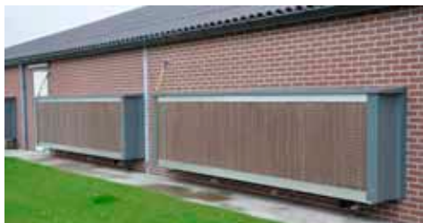
Pad koeling voor de luchtinlaat
