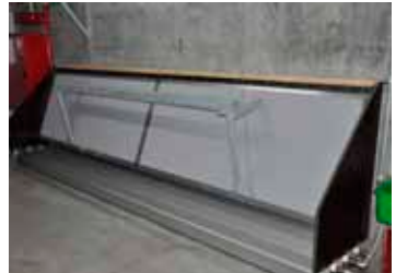
Twin-verwarmingsbuizen onder de regelbare luchtinlaatklep
