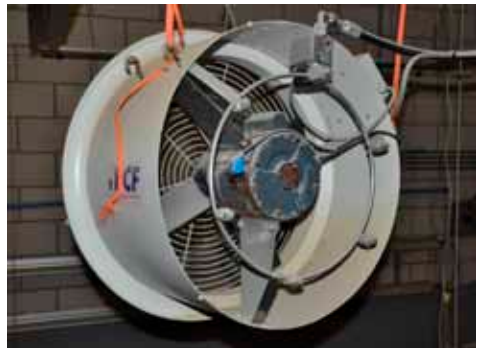
Nevelkoeling met recirculatieventilator
