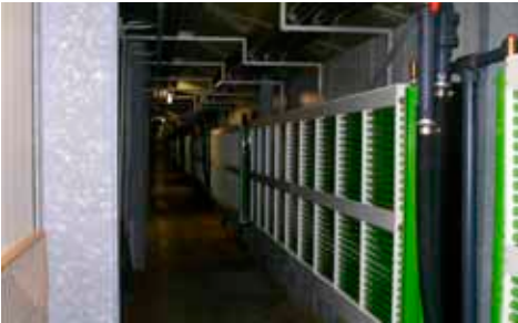
In de gang wordt de buitenlucht voorverwarmd door de water-lucht warmtewisselaar
